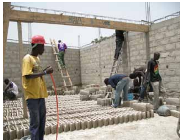
Les élèves du CTA installent l'électricité dans un nouveau bâtiment
