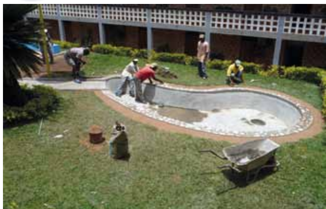
Les apprentis maçons construisent un bassin
