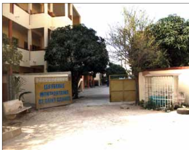
Le portail d'entrée du collège Saint-Pierre à Dakar
