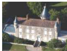
Le château d'Oriou proprement dit (parfois dit d'Orion)
