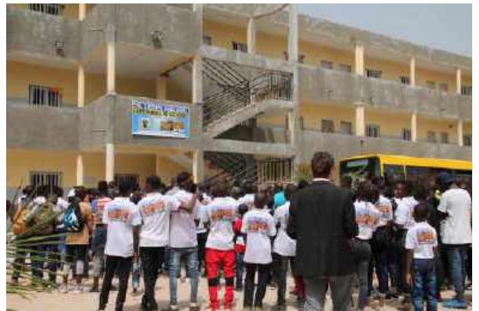
Le nouveau bâtiment.
