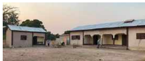
Bâtiments pour l'hébergement des moniteurs.
