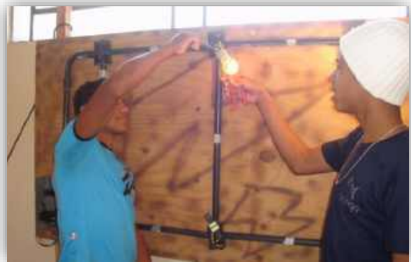
Cours de formation sur l'électricité
