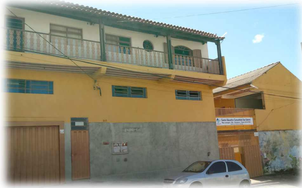
Les locaux du CECOM
