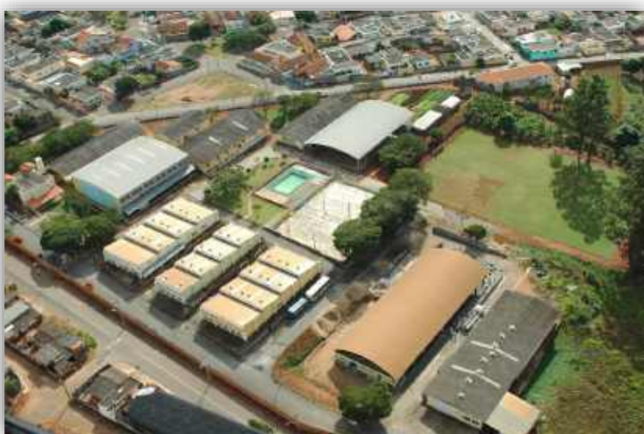
Vue générale du CAPP
