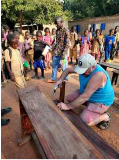
René-Luc en pleine réparation de bancs
